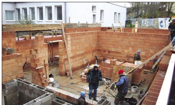
Základy novej školskej budovy
