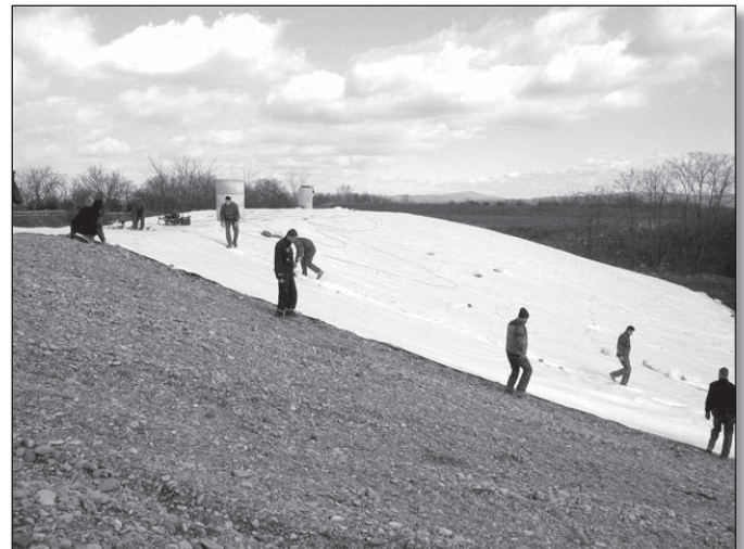
Pokryvanie skládky bielou separačnou geotextíliou.
