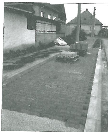
Stavebné práce na ceste za OcÚ
